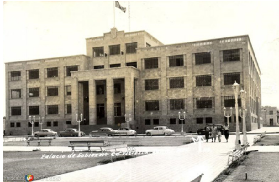
Palacio de Gobierno, ubicado entre las avenidas Hidalgo y Juárez de Victoria, en el terreno que ocupaba el "Teatro Juárez"
